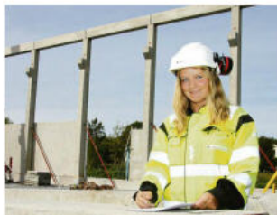
LEDER: Linda Bamberg er prosjektleider for byggingen av utnytt kontor og verkstedbygg på Horvane.
